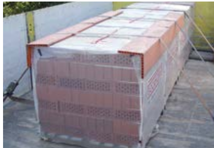
Abb. 7-49 Ladungssicherung durch Niederzurren
