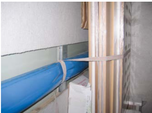
Abb. 10-50 Durch Umreifen gut gesichert: kleinere Partien
